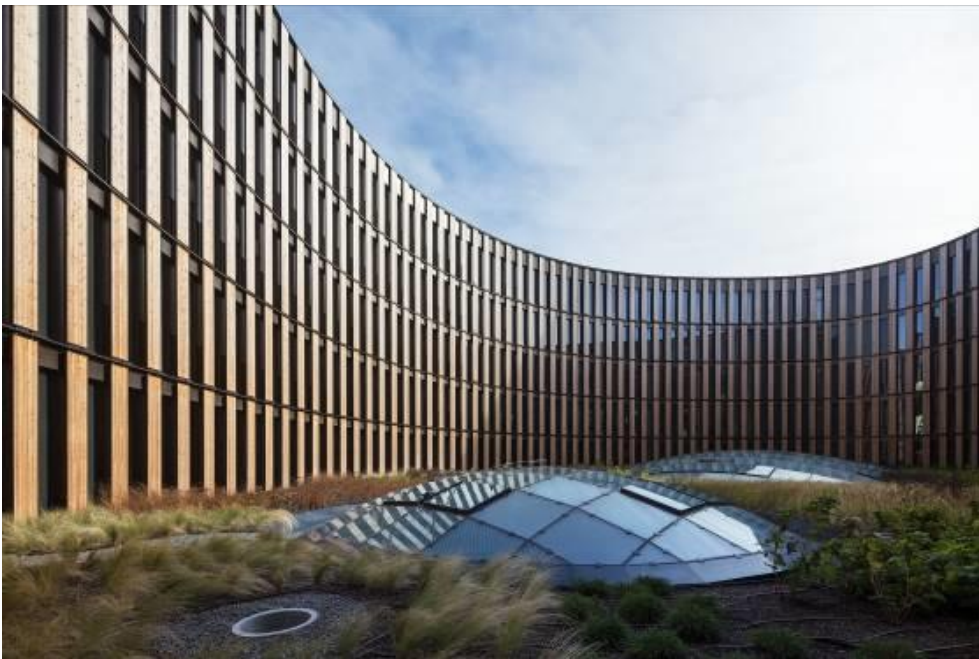
Bildunterschrift: An der Aluminiumfassade des Freiburger Verwaltungszentrums, einer Pfosten-Riegel-Konstruktion, sind vertikale Photovoltaikmodule platziert, an Flächen, an denen die Sonneneinstrahlung als optimal berechnet wurde.
