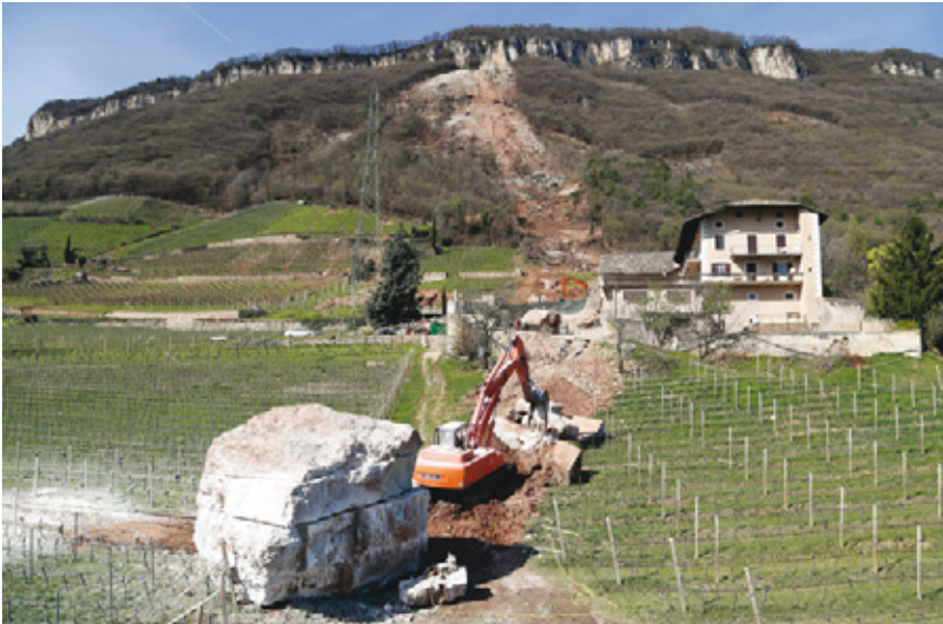
Bei Tramin rollte 2014 ein 600t schwerer Dolomitfindling ins Tal und blieb bei einem Bauernhof stehen. Die südtirol.stein GmbH hat den Brocken zerlegt und weiterverarbeitet.
