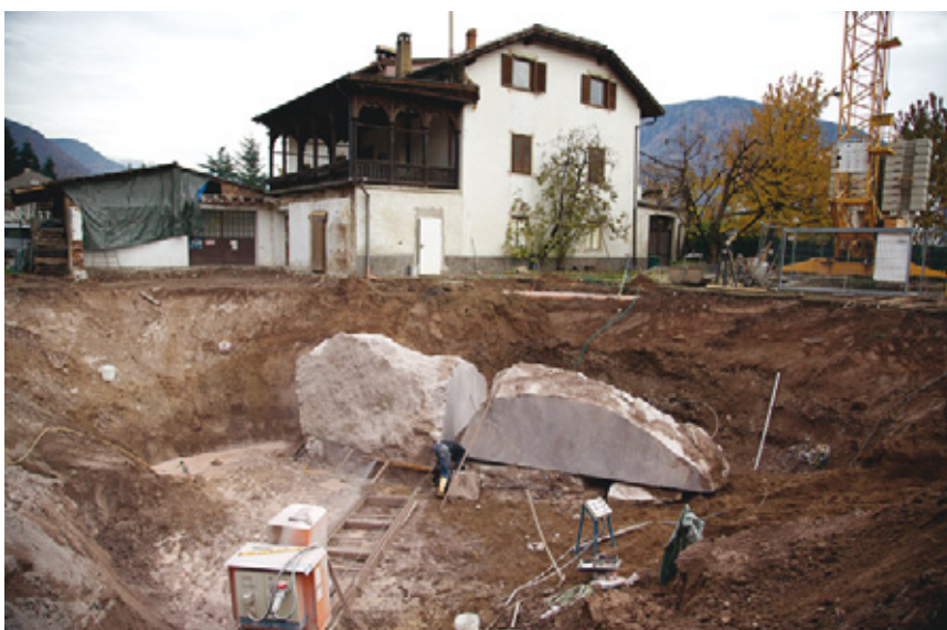
Abbau eines BOZENER PORPHYR-Findlings
