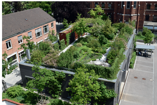
Abb. 5: Intensive Dachbegrünung (Dachgarten). Zusätzliche Nutzfläche für Menschen. Quelle: BuGG
