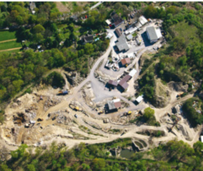
Steinbruch und Werksgelände der Firma Grandi in Herdecke
