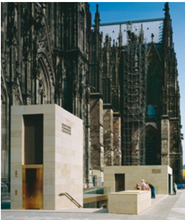
Mit Ruhrsandstein der Firma Grandi bekleidetes Zugangsgebäude zum Kölner Dom Foto: Dombauarchiv Köln, Foto: Matz u. Schenk, 2009
