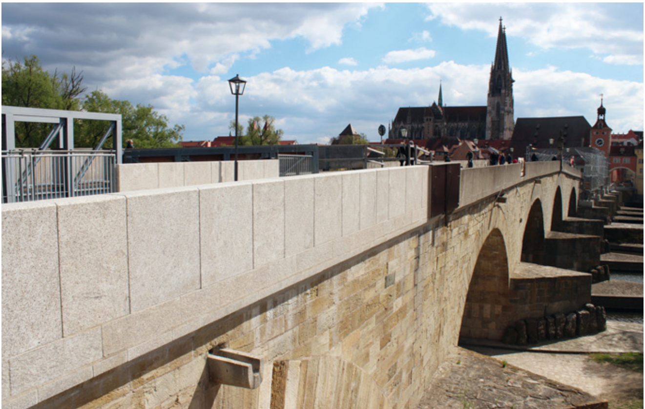
Prestigeprojekt: Die zum UNESCO-Welterbe zählende Steinerne Brücke in Regensburg wird mit FLOSSENBÜRGER GRANIT der Granitwerke Baumann erneuert. Fotos: Firma
