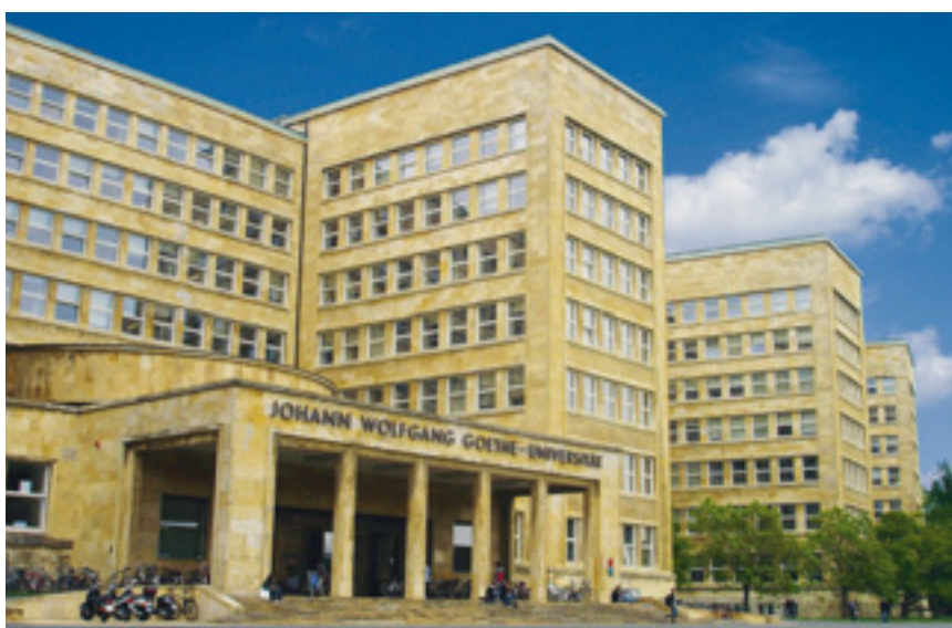
Das I.G.-Farben-Haus in Frankfurt a.M. Heute wird der vor mehr als 80 Jahren mit Fassaden aus CANNSTATTER TRAVERTIN errichtete Bau von der Johann Wolfgang Goethe-Universität genutzt. Foto: Dr. H. Wolfgang Wagner
