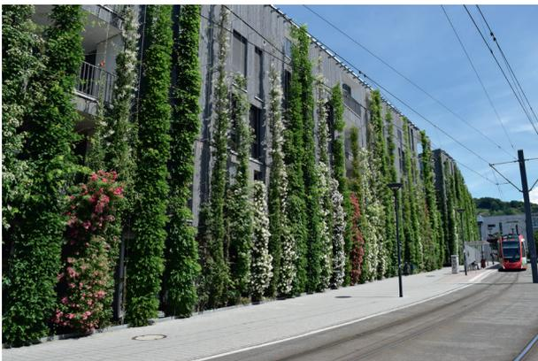
Abb. 6: Bodengebundene Fassadenbegrünung mit Kletterhilfe.
