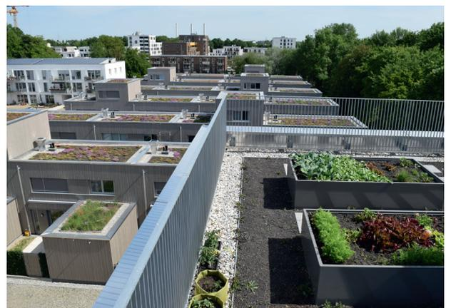
Abb. 17: In 2019 wurden 83,5 % Extensiv- (im Bild links) und 16,5 % Intensivbegrünungen (im Bild rechts) ausgeführt. Quelle: BuGG
