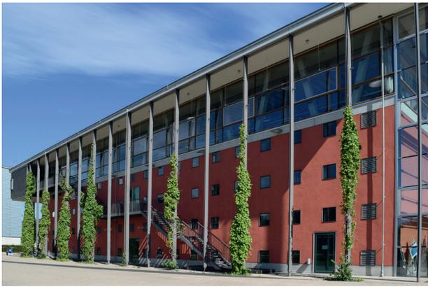
Abb. 30: Ein laufender Meter lineare Kletterhilfe kann je nach Abständen unterschiedliche Flächengrößen einnehmen, ... Quelle: BuGG
